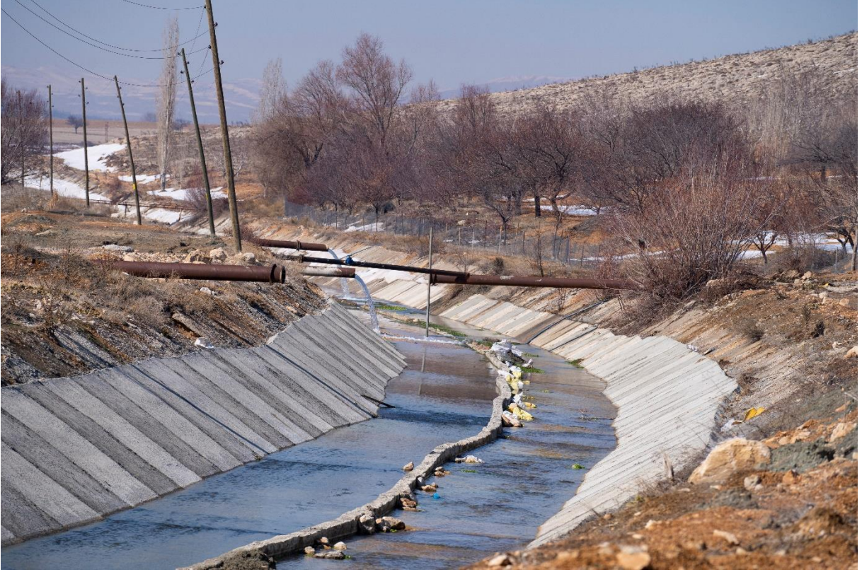
Fotoğraf 1 - Kahramanmaraş Kışlaköy Kömür Sahası Susuzlaştırma Çalışmaları
