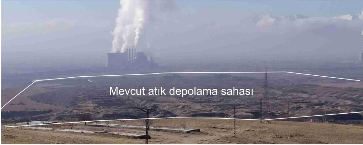
Foto 6-4. Mevcut atık depolama sahası (kuzeyden bakış).
