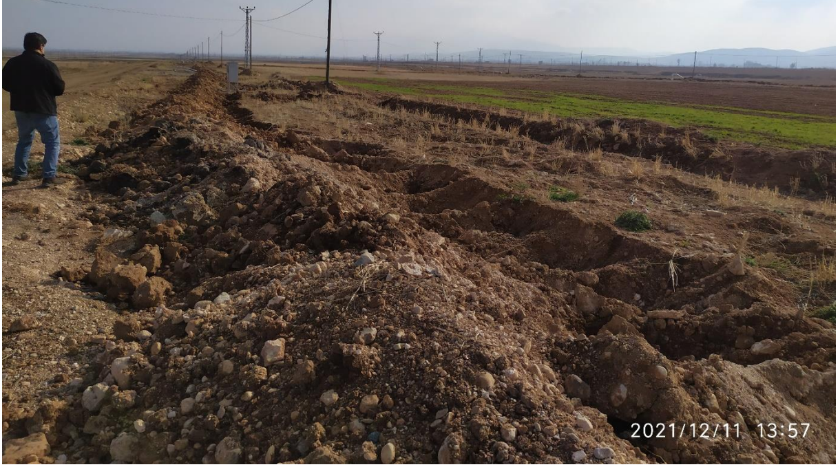
Foto 4-2: Ahmetçik formasyonu susuzlaştırma kuyuları (100 m aralıklı).
