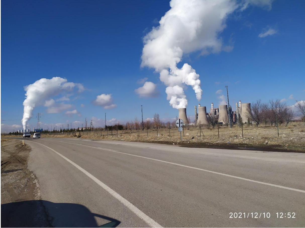
Foto 6-3: A ve B termik santralleri (A-Termik Santrali sağda, B-Termik Santrali solda).
