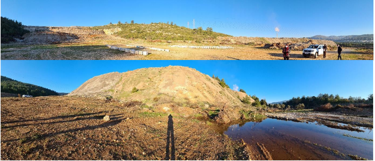
Foto 8-4. Yeniköy Termik Santrali'nin güneybatısındaki kül tepelerinden bir görüntü. Kuşaklama kanalı bulunmayan kül yığınları çevresinde biriken yüksek elektriksel iletkenliğe sahip su birikintileri.
