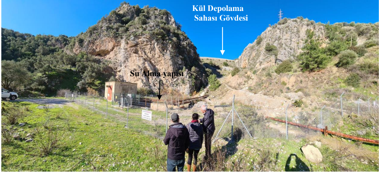
Foto 8-3. Kemerköy kül-cüruf depolama sahasına Ahmetler Deresi vadisinden bakış ve vadi içinde bulunan su alma yapıları.
