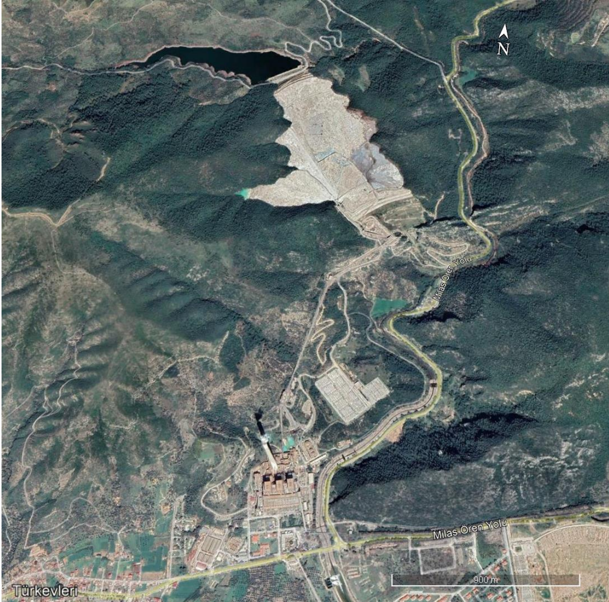
Şekil 8-2. Kemerköy Termik Santrali ve kuzeyindeki kül-cüruf depolama alanından bir görünüm.
