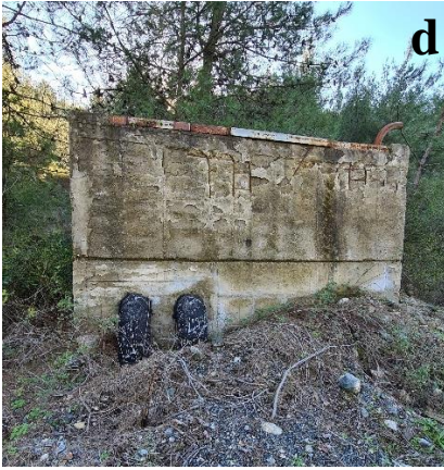
Foto 8-2. a) Kemerköy Termik Santrali kül depolama sahasını çevreleyen kuşaklama kanalı, b) ve c) Kuşaklama kanalından kül depolama sahası membaında yer alan Ahmetler Barajı'na yapılan deşarj, d) ve e) Ahmetler Barajı'nın taşkın anında sularını deşarj etmek için Karaçayır Deresi'nin güney sahilinde kurulan yapılardan birer görünüm. 2022 ocak ayında yapılan saha gezisinde Karaçayır Deresi'ne Ahmetler Barajı'ndan herhangi bir tahliyenin olmadığı görülmüştür.
